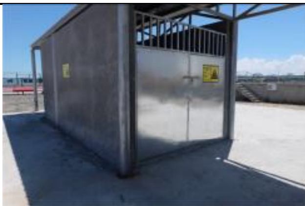
危险废物暂存库
